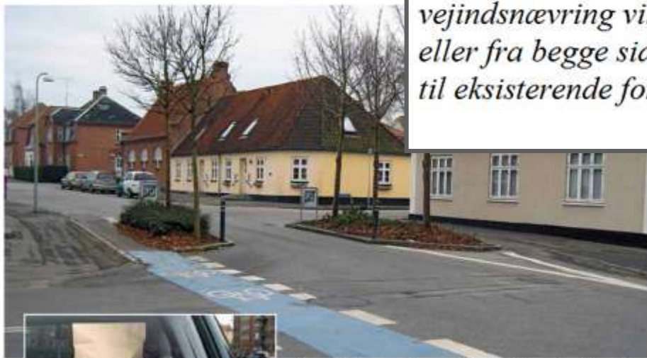
Figur 4. Chikanen på Dagsmarsgade mellem Anlægsvvej og Schandorfsvej skaber stor forvirring blandt bilisterne og resulterer i uheld ved Anlægsvvej. Ved højresving mod Anlægsvvej er der stor risiko for at bilisterne overser cyklister, der kører bagom hellen. Der er sket 3 uheld med cyklister i krydset. To af disse kom til skade. Chikanen foreslås fjernet.
